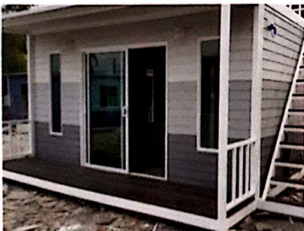
บ้านประกอบเสร็จ
