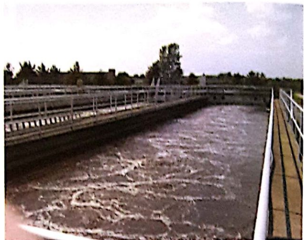
บ่อบำบัดน้ำเสีย
