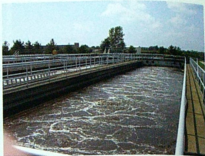
บ่อบำบัดน้ำเสีย
